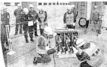
事故プラントのポンプ用遮断器の健全性確認と交換復旧訓練を行う社員ら ＝東京電力福島第二原子力発電所
