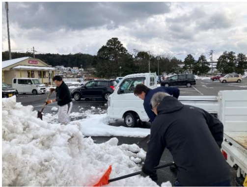
除雪作業①
