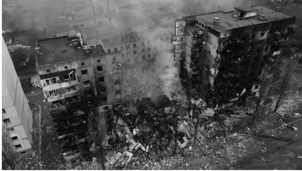
ロシア軍によって破壊された建物(キーウ) (出典:cnn.co.jpより)
