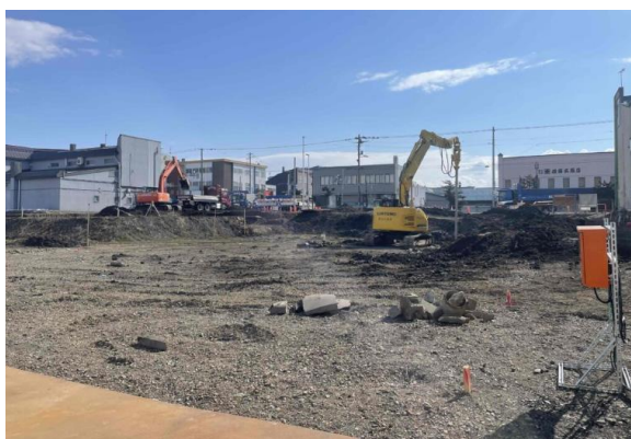
砂川駅前地区整備の様子
