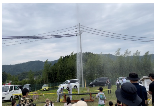
配管修理実演
